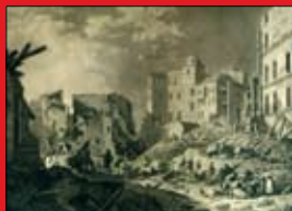
Ruinas de Zaragoza Ruinas del Seminario por la explosión de 1808
