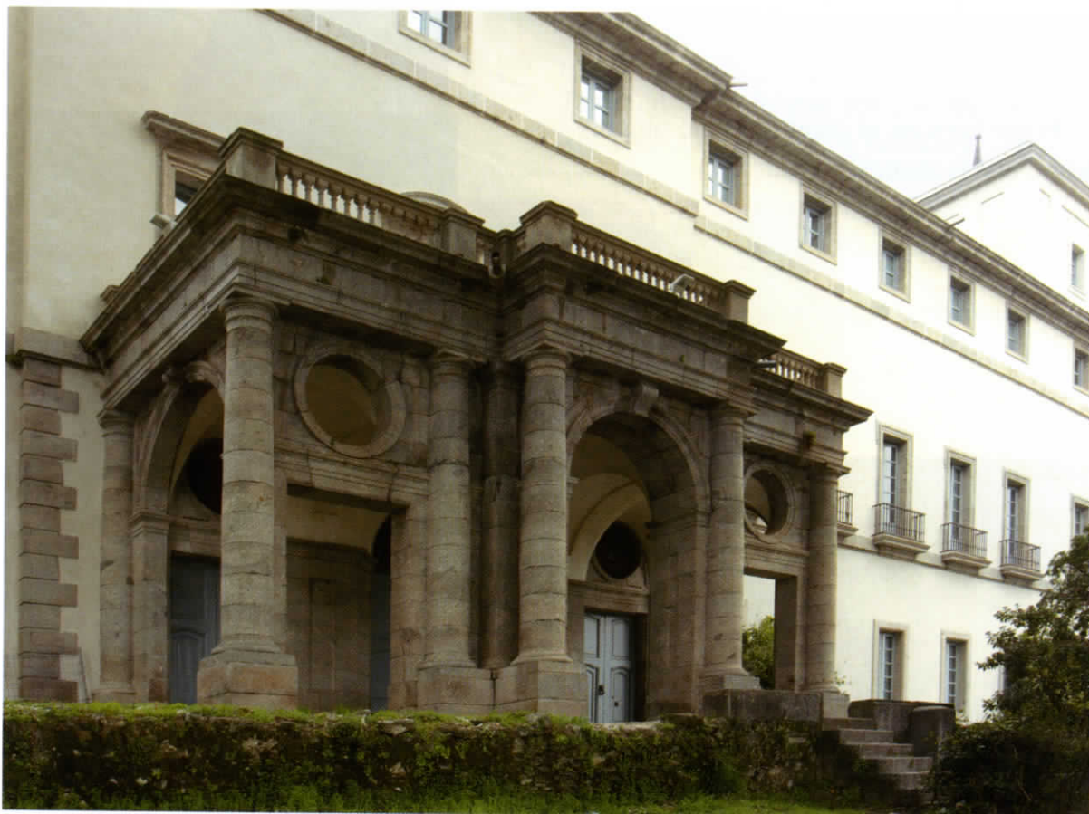
Palacio de Arenas de San Pedro
